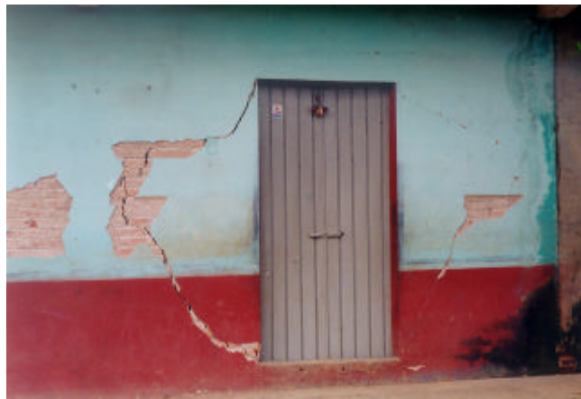
Figura 3.23 Daño en las aberturas de muros de mampostería por ausencia de elementos de confinamiento
