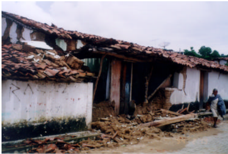
Figura 3.69 Vivienda de adobe dañada por el sismo del 30 de septiembre de 1999
