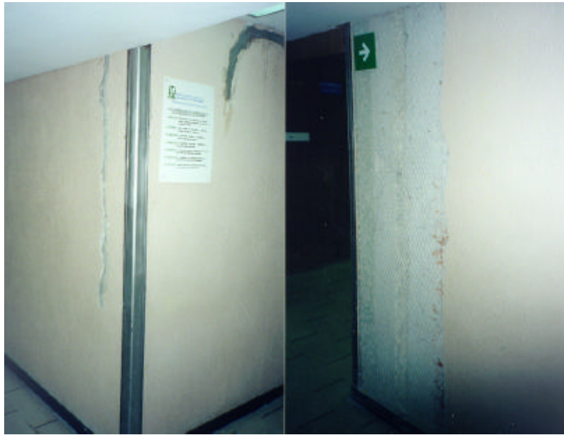
Figura 3.17 Muros de mampostería reparados
