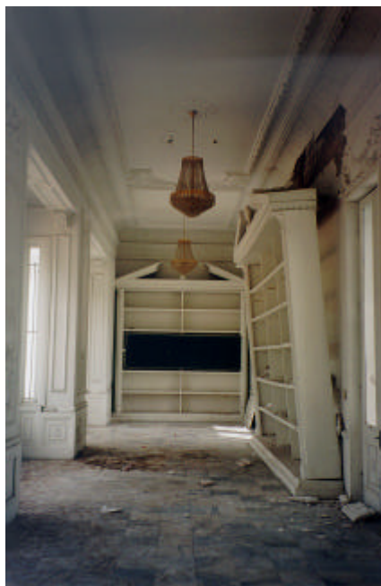
Figura 3.7 Daño en malla de acabados del edificio de la Escuela de Medicina de la UBJO
