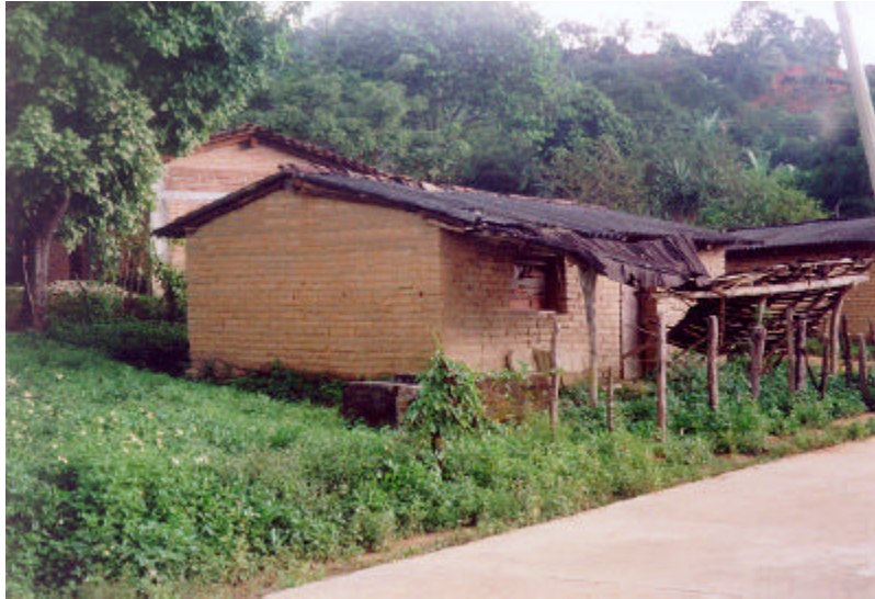
Figura 3.21 Estructura de adobe con buen comportamiento, presenta traslape de tabique en las esquinas
