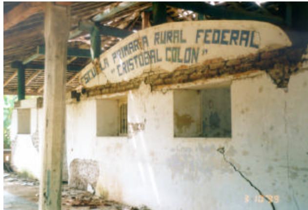
Figura 3.66 Daño en los muros de adobe y techo del edificio
