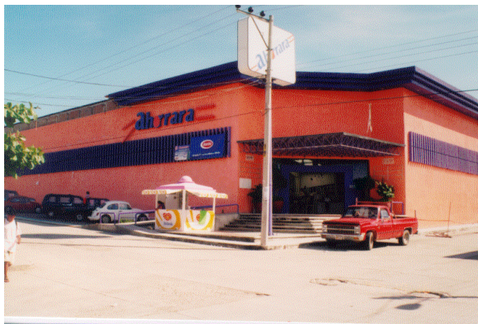
Figura 3.38 Vista general del centro comercial
