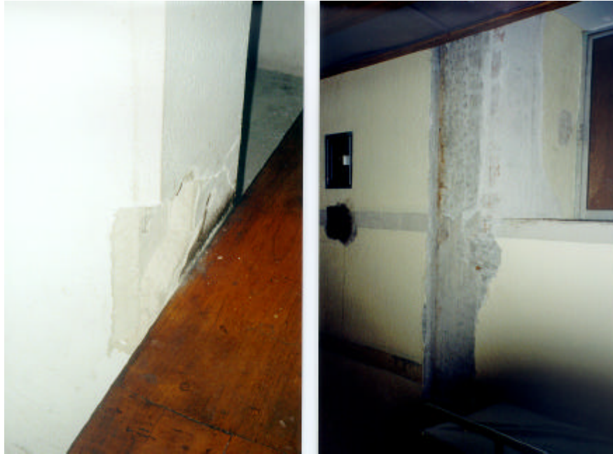
Figura 3.16 Daño en aplanados y restitución de los mismos
