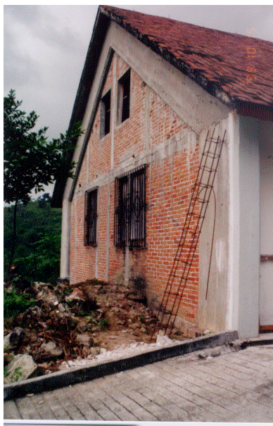
Figura 3.31 Fachada posterior sin daño
