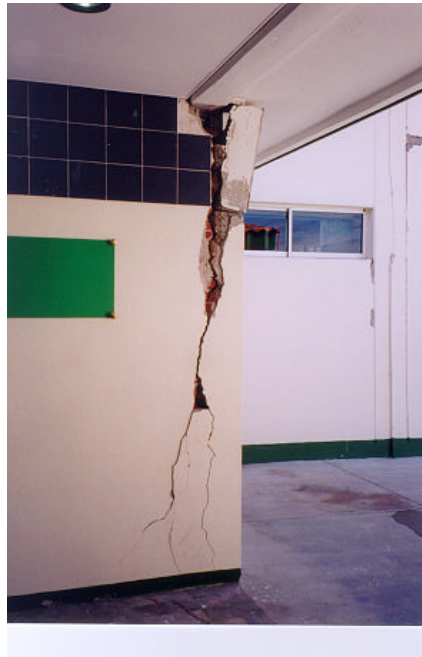
Figura 3.50 Detalle del anclaje inadecuado de un castillo en la parte frontal del edificio
