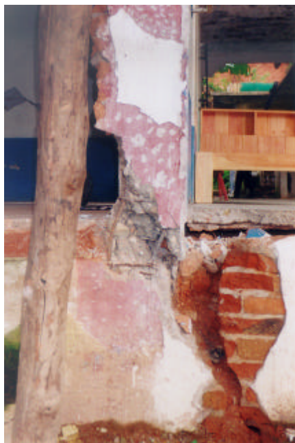
Figura 3.25 Falla por corte en un y castillo
