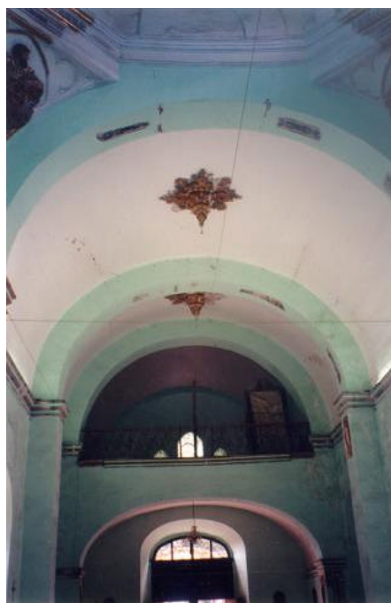
Figura 3.11 Agrietamientos ligeros en arcos de la bóveda principal
