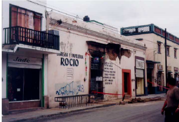
Figura 3.4 Desprendimiento de adobe en la fachada de edificación de un nivel
