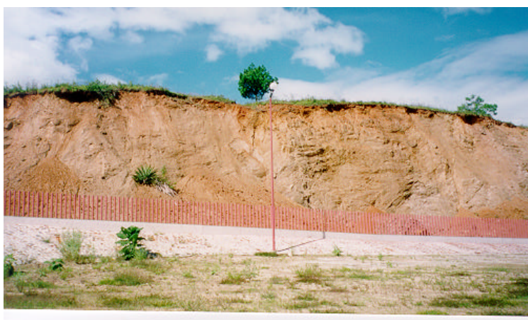
Figura 3.46 Muestra del corte efectuado para generar el terraplén
