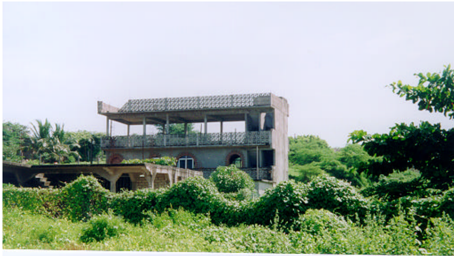
Figura 3.42 Vista frontal de la edificación
