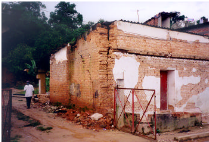
Figura 3.19 Daño en edificación de adobe sin liga entre muros ortogonales
