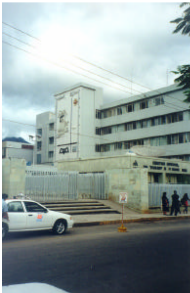
Figura 3.13 Fachada del Hospital Civil Dr. Aurelio Valdivieso
