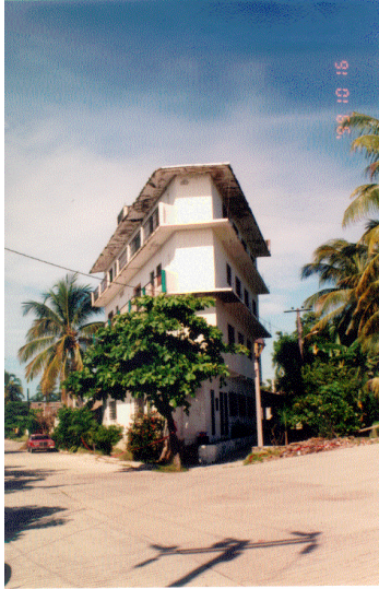
Figura 3.40 Vista frontal del edificio
