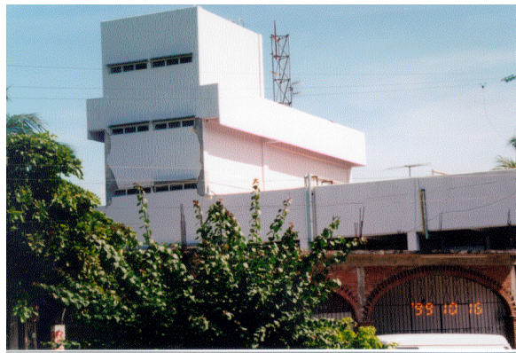
Figura 3.41 Vista lateral de la central de Telmex
