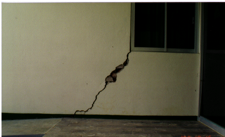
Figura 3.57 Daño moderado en un muro de mampostería confinada
