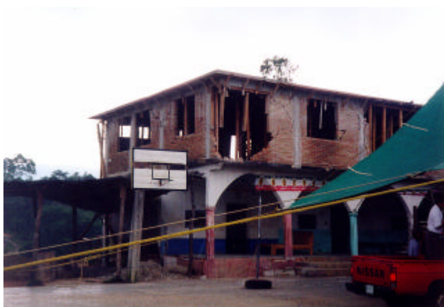
Figura 3.26 Colocación inadecuada de castillos en la esquina superior anterior del edificio
