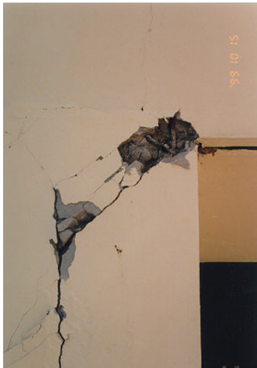
Figura 3.51 Detalle del anclaje inadecuado de un castillo en el cuarto de aire acondicionado
