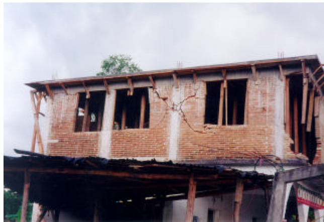
Figura 3.24 Daños derivados por una distribución inadecuada de elementos confinantes en la mampostería
