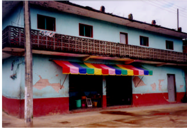
Figura 3.22 Estructura de mampostería de tabique tradicional en la región
