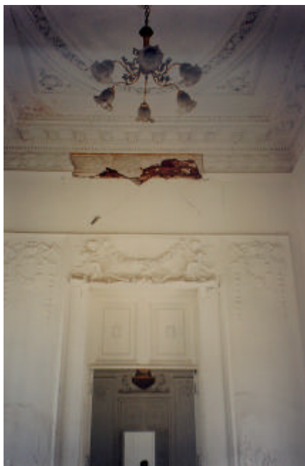
Figura 3.8 Daño en dinteles de puertas de la Escuela de Medicina de la UBJO
