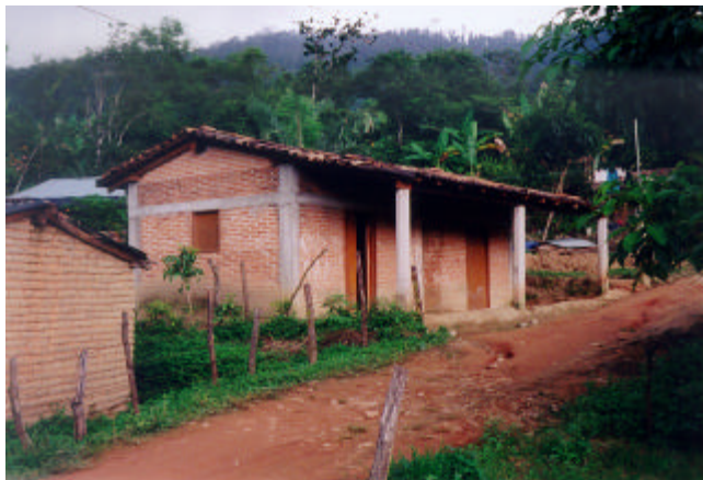
Figura 3.27 Edificación de tabique rojo recocido con estructuración y comportamiento adecuados
