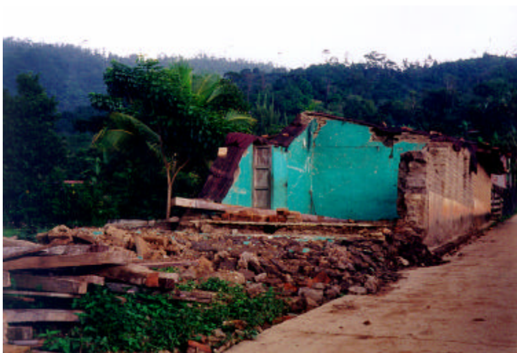
Figura 3.20 Daño total en edificación de adobe por ausencia de liga entre muros
