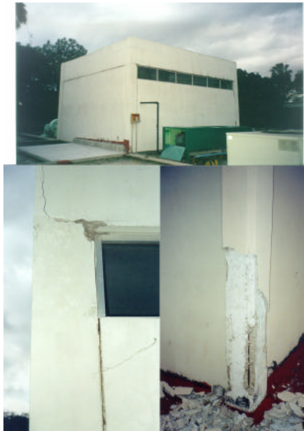
Figura 3.18 Características del daño en la estructura donde se aloja el cuarto de máquinas
