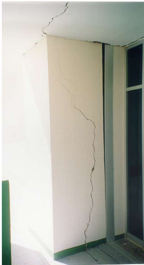
Figura 3.52 Desplomo de la columna del cuerpo III, respecto a la del cuerpo II (vista superior)
