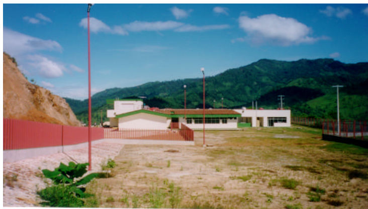
Figura 3.45 Vista general del terraplen donde se desplanta la estructura del Hospital
