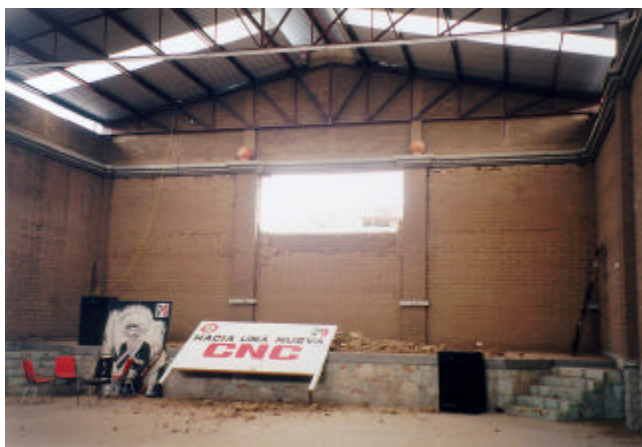
Figura 3.9 Daño en muro de adobe del auditorio de la CNC
