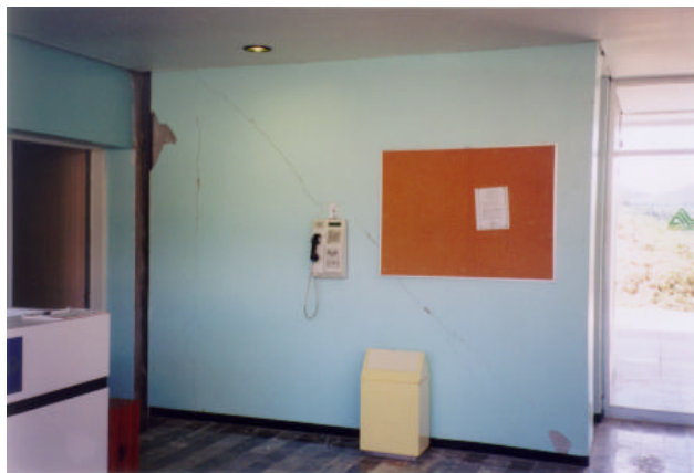
Figura 3.55 Daño ligero un muro divisorio de mampostería confinada
