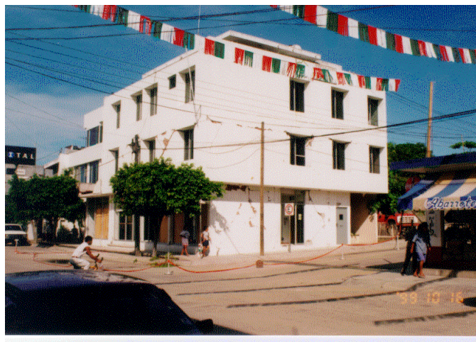
Figura 3.34 Vista lateral de la construcción
