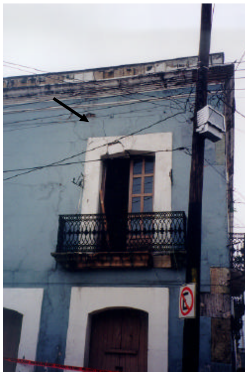
Figura 3.3 Daño en el dintel de la edificación de dos niveles ubicada frente al Teatro Macedonio Alcalá
