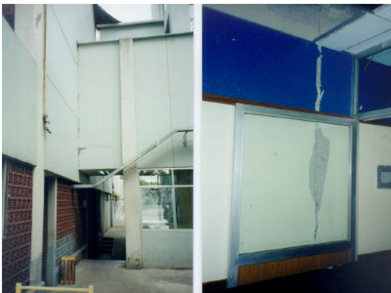
Figura 3.14 Junta de construcción entre cuerpos del complejo hospitalario y agrietamiento ligero en la misma, visto desde el interior del inmueble
