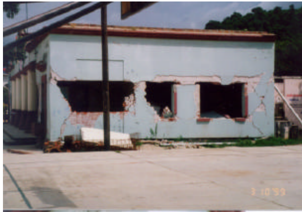
Figura 3.68 Daño en el muro lateral derecho del palacio municipal
