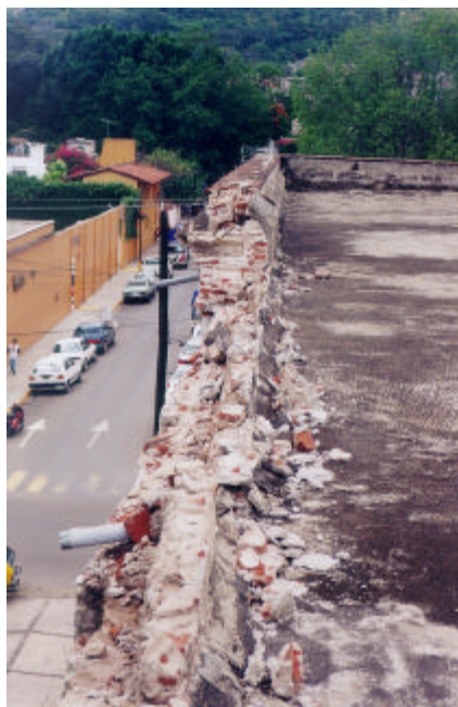
Figura 3.6 Estructura del pretil de remate en la fachada de la escuela Moisés Sáenz de la Garza
