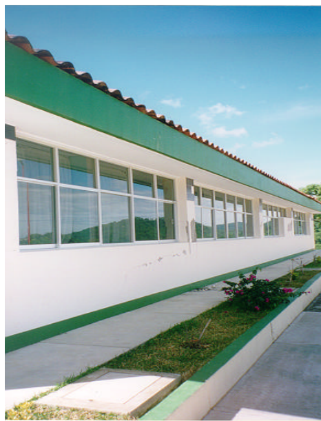
Figura 3.47 Vista de las columnas de la fachada norte
