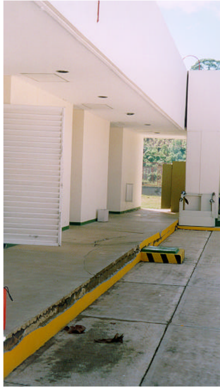
Figura 3.54 Hundimiento diferencial en la zona de la banquetta del cuerpo IV
