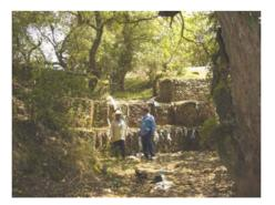
Figura 1.64 Presa de gaviones azolvada
