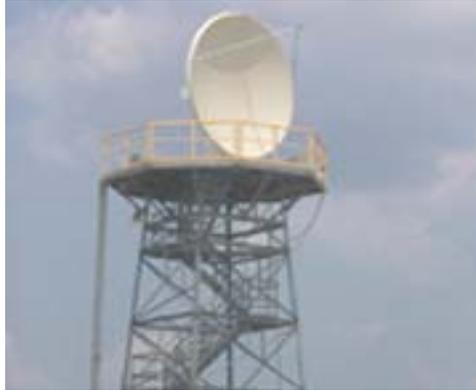
**Figura 3.13 Radar meteorológico tipo Doppler**
