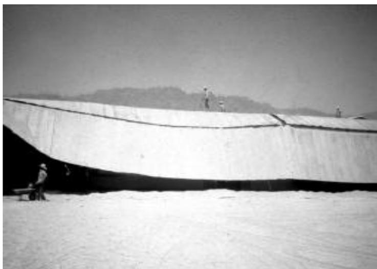
**Fig. 26.** El peso de la ceniza puede producir el colapso de instalaciones inadecuadamente diseñadas. La foto muestra el techo caído de la terminal camionera de Pichualco, a unos 20 km del volcán El Chichón, que cayó por efecto de una acumulación relativamente pequeña de ceniza.
