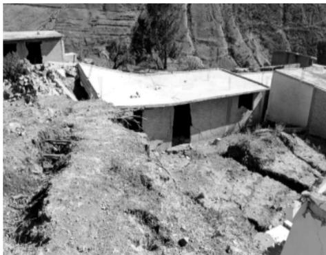
**Figura 22.** Rompimiento y movimiento en bloques de un deslizamiento con mecanismo traslacional
