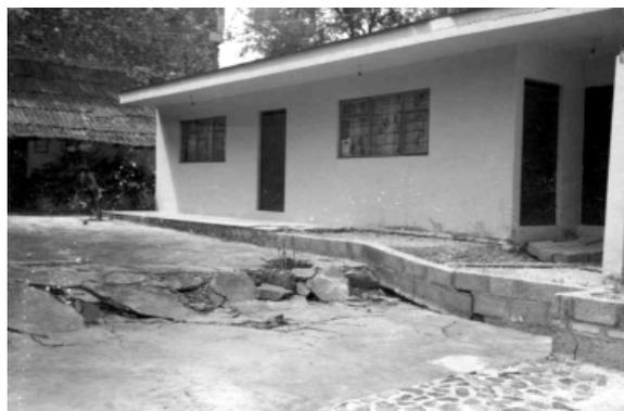
Figura 16. El rompimiento de muros y pisos es un indicio de inestabilidad
