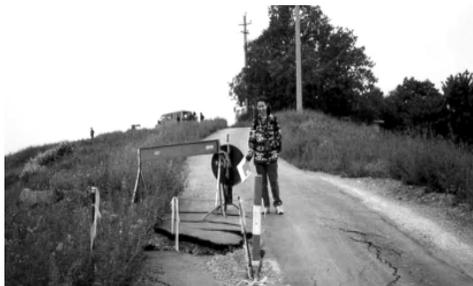
**Figura 21.** La presencia de grietas semicirculares, el hundimiento de algunas partes de la carretera y los postes desalineados, son los principales síntomas de inestabilidad que se pueden observar en esta región
