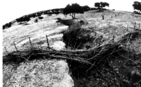
**Figura 52**. Ensayo de diferentes hidrotecnias para el control de torrentes y cárcavas de gran longitud aprovechando materiales del propio terreno.
