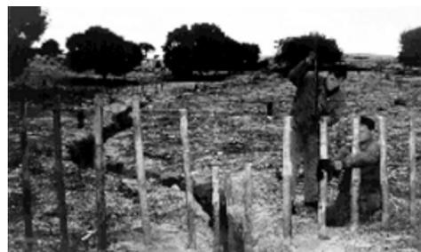
**Figura 51**. Estabilización de laderas por medios mecánicos.
