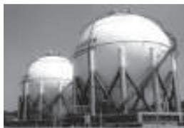
limitada y si no es suficiente, será necesario utilizar un anillo de anclaje o una cimentación fuerte. A medida que aumenta la presión se hace necesaria la curvatura en todas las superficies. De manera que se pueden construir tanques en forma de esferas, elipsoides, estructuras toroidales y cilindro circulares con cabezas torisféricas, elipsoidales o hemisféricas.
