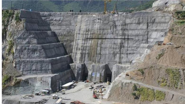
**Figura 5. Obra de toma del proyecto hidroeléctrico La Yesca**
