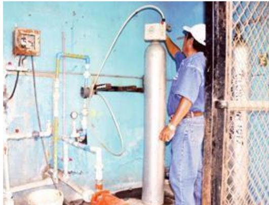
**Figura 26. Cloración con gas en un sistema de agua potable**
