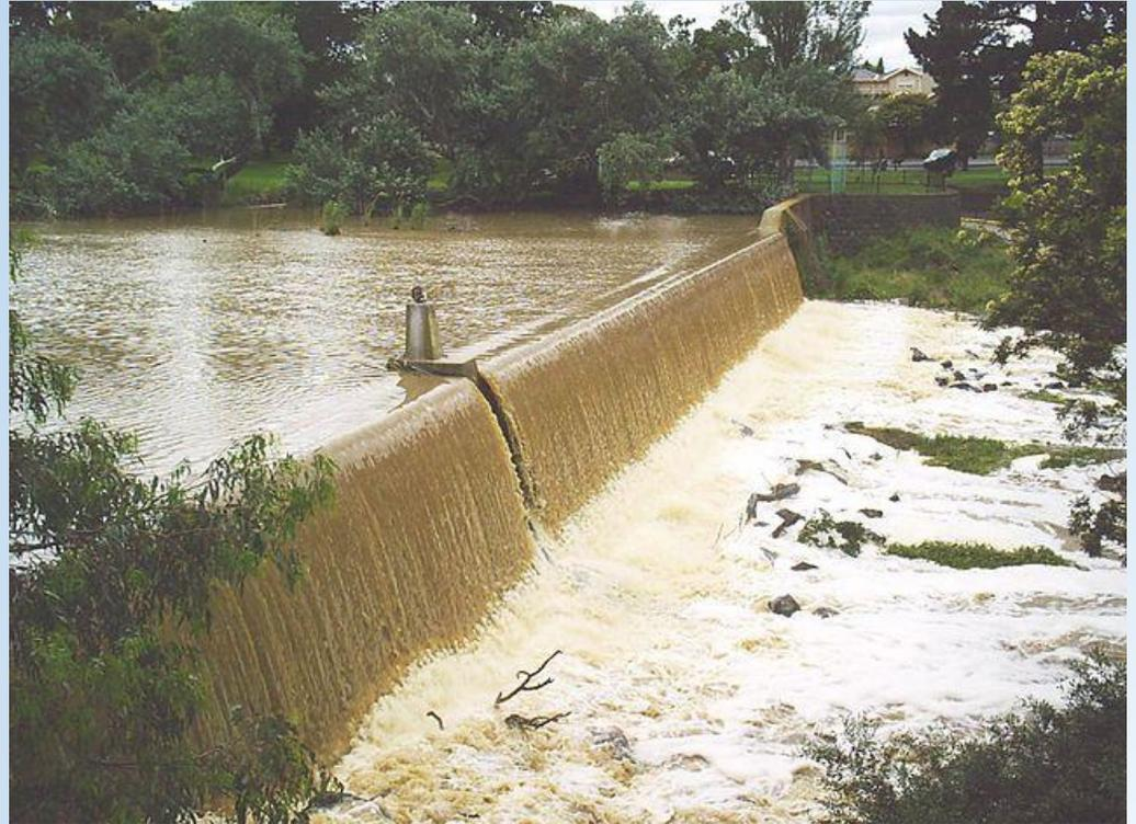
***Los vertederos permiten a los hidrólogos un método simple para medir el caudal en flujos de agua.***
