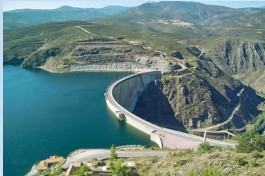
PRESA DE HORMIGON (DE ARCO-BOVEDA)
