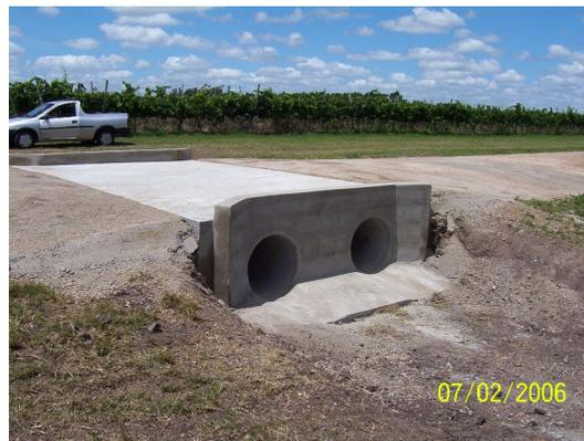
Cabeceras de alcantarillas construidas con bloque hueco vibrado y varillas de hierro, que sustituyen los encofrados, haciendo hormigón armado en el lugar, disminuyendo costos y aumentando la productividad.
