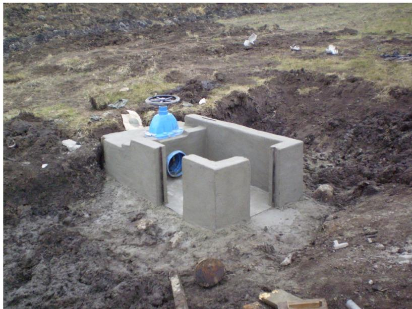
Fig.7.-Obra de toma en embalse, con caño de 250 mmPVC, y dos salidas, una a canal derecho que pasa por contrataipa, y otra a canal izquierdo canal de ladera.
