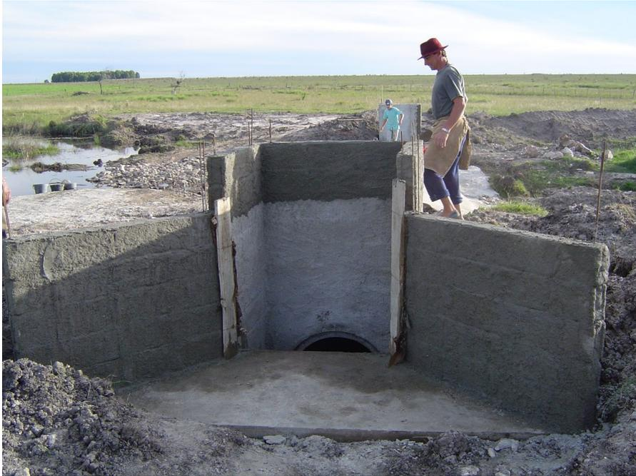
Cabecera aguas arriba del canal para pasar una Cañada en un sistema de distribución hídrica para riego. Los cabezales construidos con bloques huecos de hormigón comprimido, por lo cual no es necesario tablas de encofrado, simplificando la construcción de hormigón armado, esencial en condiciones de campo “tierra adentro”.
