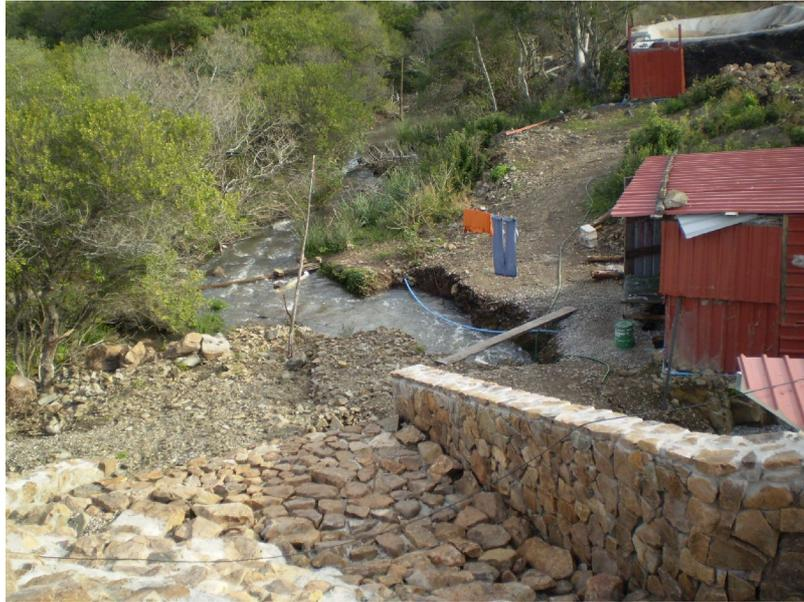
Fig.6.-Obra de desagüe principal (o mínimas) funcionando, compuerta toda abierta caño de 315 mmPVC
