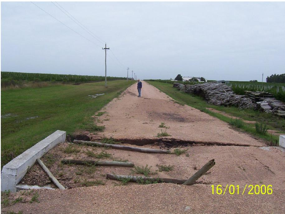
Alcantarillas mal calculadas o puestas a "ojo" y mal instaladas desde el punto de vista estructural, dan como resultado el colapso total de la estructura luego de unos años de instaladas, como consecuencia del paso sobre la misma de excedentes hidráulicos con elevada frecuencia.
