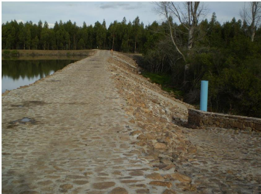
Fig.5. Presa vertedero de tierra y enrocado, pensada para colocar una miniturbina, tubería que asoma es el sistema para evitar golpe de ariete en caso de colocar una turbina.-
